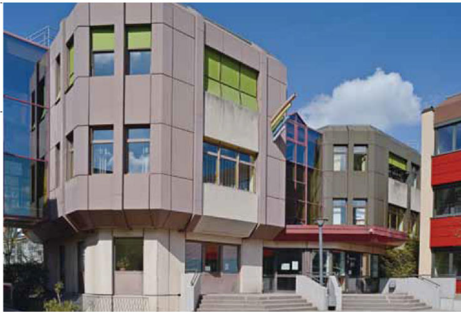
Verbindungsbau zwischen Real- und Grundschule
